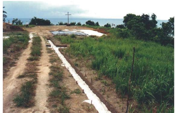
**Figura 28:** Reaterro das áreas escavadas com sedimento arenoso branco, sucedido por sedimentos retirados durante a escavação.
