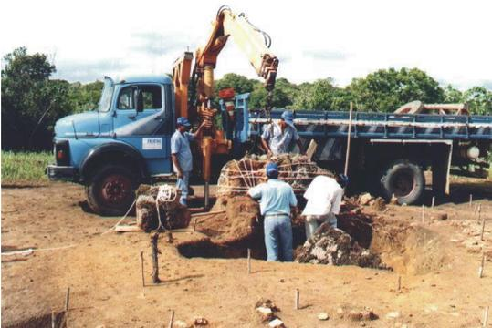
**Figura 22:** Preparação do bloco menor de alvenaria para o içamento. À esquerda dele está o pedaço da estrutura que se desprendeu durante a primeira tentativa.
